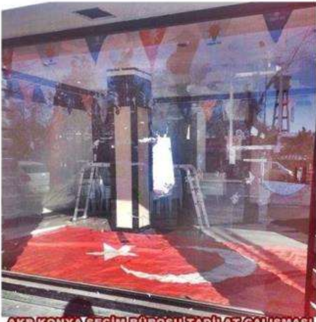
AKP KONYA SEÇİM BÜROSU TADİLAT ÇALIŞMASI TÜRK BAYRAĞI ZEMİNİ BOYADAN KORUYOR
